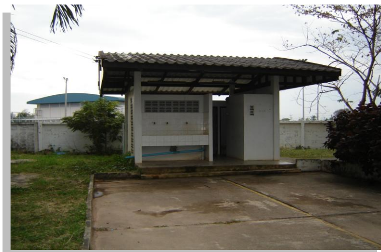
สุขาด้านหลังอาคาร 5
