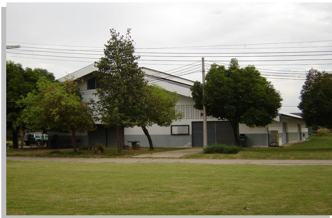
อาคารโรงฝึกงานแผนกช่างเชื่อมและเทคโนโลยีพื้นฐาน
