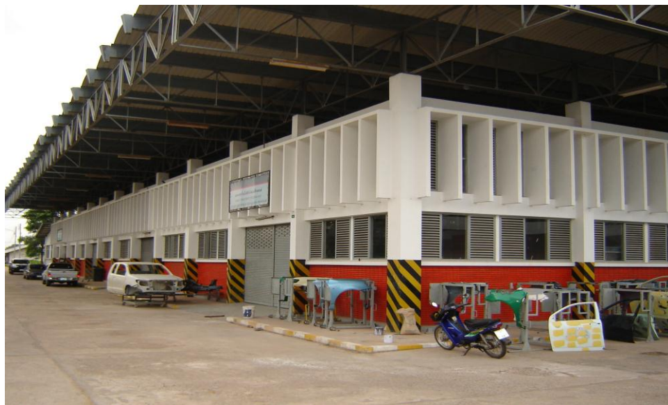
อาคารฝึกงานแผนกวิชาตัวถังและสีรถยนต์
